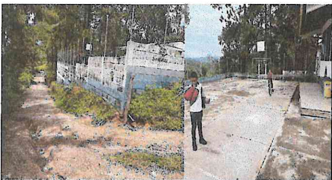
Foto 3: Pintura en Muros interiores y Exteriores (aula, cocina y sanitarios)
