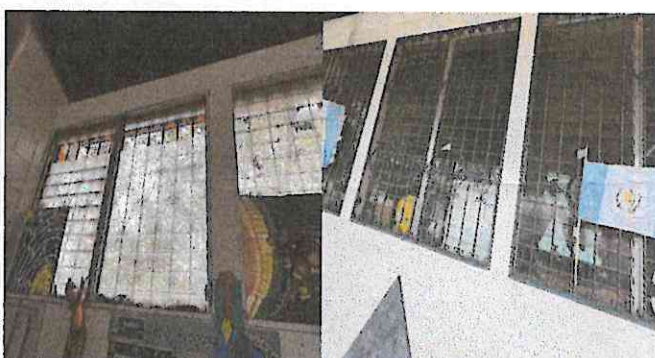
Foto 4: Ventanas: sustitucion de ventanas por PVC
